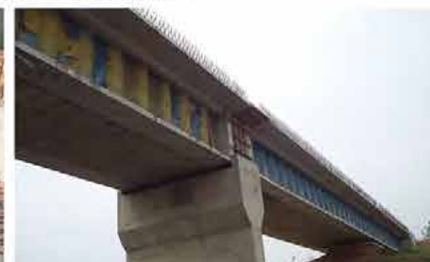
浇筑顶、底板湿接缝砼，形成组合箱梁
