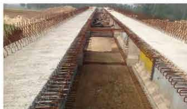
浇筑顶、底板湿接缝砼，形成组合箱梁
