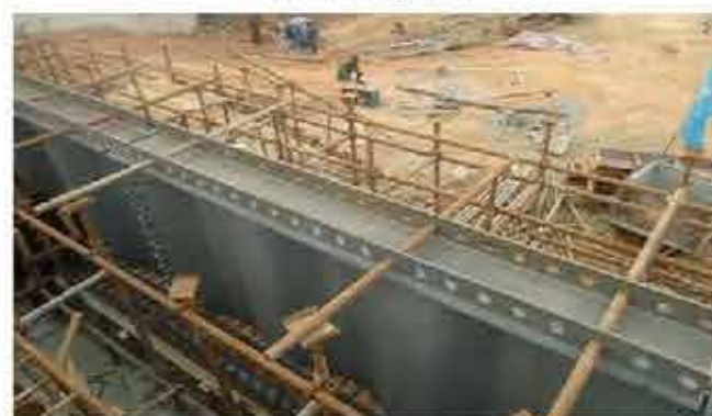
钢腹板安装定位
