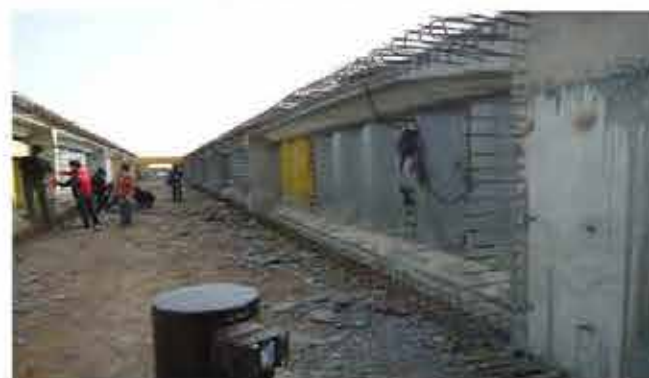
波形钢腹板PC工字梁浇筑完成、架设
