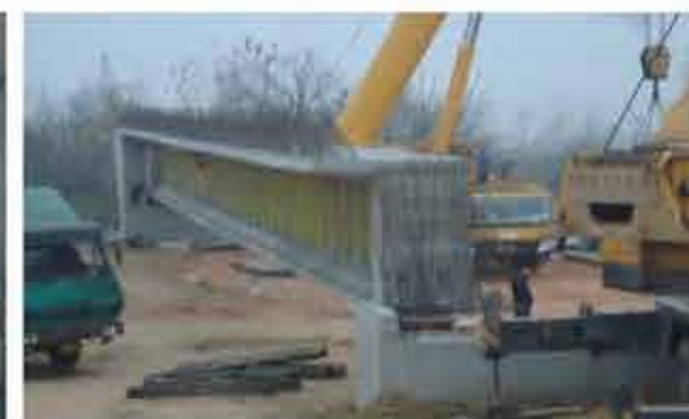
波形钢腹板PC工字梁浇筑完成、架设
